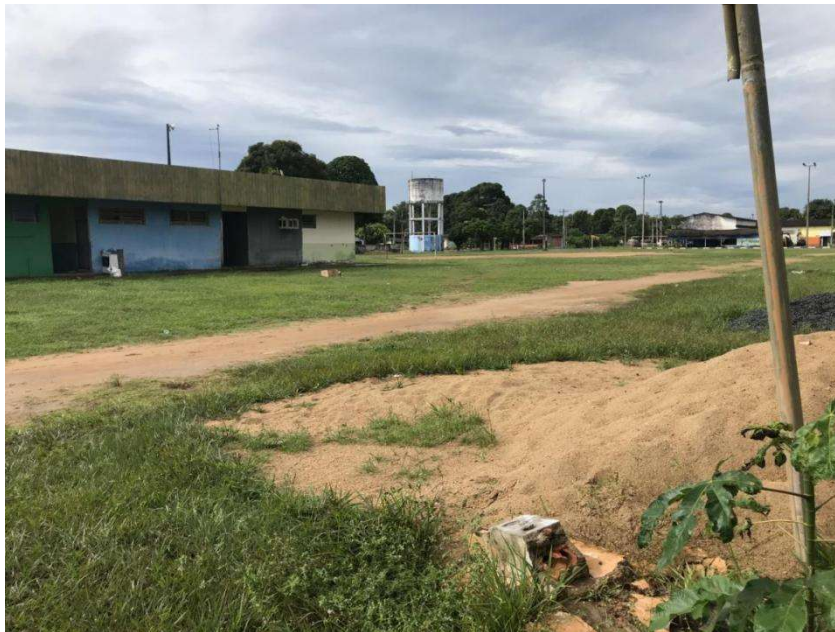
Foto 04: Vista do terreno de construção da unidade - Lateral
