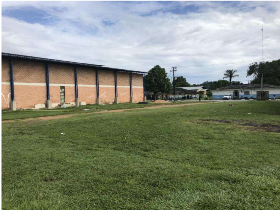
Foto 05: Vista do terreno de construção da unidade - Lateral
