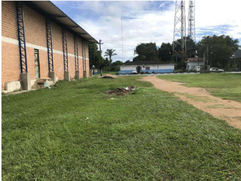
Foto 03: Vista do terreno de construção da unidade - Fundo
