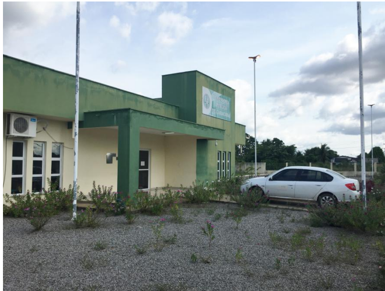
Figura 01: Pintura e placa da Defensoria apresentando aparência de desgaste; Luminárias externas acesas durante o dia devido à falta de relé fotoelétrico; Ausência de caixa de passagem para a verificação do aterramento.
