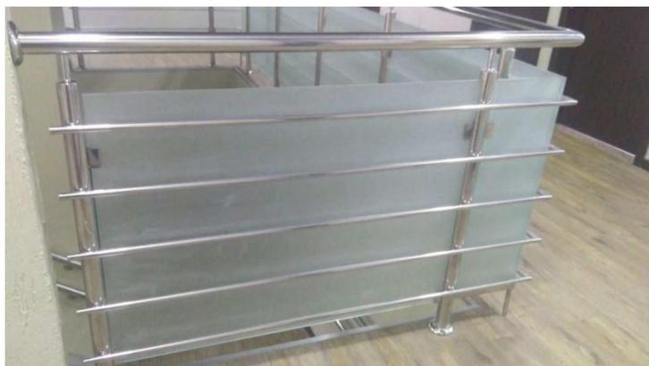
Fornecimento e instalação de guarda-corpo em aço inox de 2" com 5 faixas paralelas em tubo 5/8" e corrimão superior dtubo= 1 1/4" (o espaçamento máximo entre as linhas paralelas não poderá ser superior a 15cm)
