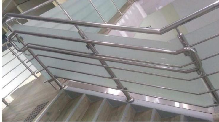
Fornecimento e instalação de guarda-corpo em aço inox de 2" com 6 faixas paralelas em tubo 5/8" com corrimão paralelo em dois níveis conf.NBR 9050
